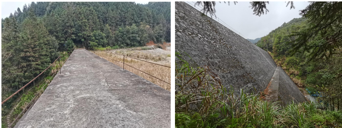
尾矿坝坝顶及下游坡面
